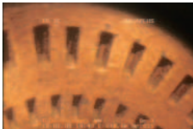
Abb. 8 Gereinigter Steinzeugbrunnen ohne Beschädigungen, regeneriert mittels Druckwellenimpulsverfahren
