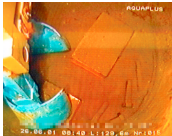
Bergung von verschiedenen Fremdkörpern mittels eines Hydraulikgreifers aus dem Brunnensumpf
