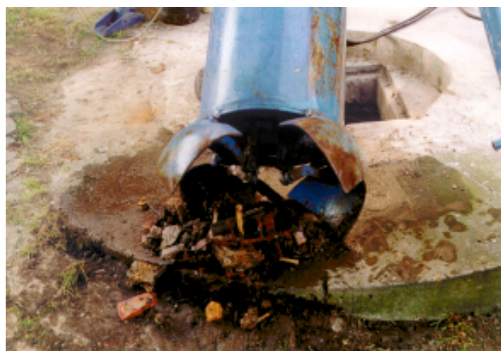
Fremdkörperbergung aus einem Brunnen mit einem Löffelgreifer
