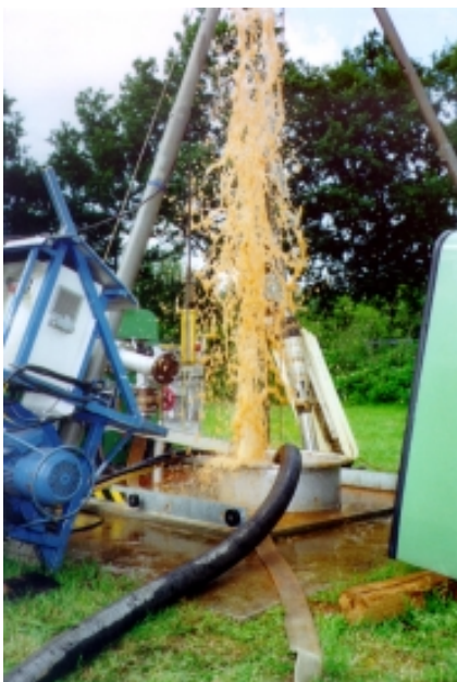
Puls mit einem Druck von ca. 20 bar in einer Tiefe von 20m. Die Wirkung kann hier deutlich durch die Fontäne aus einem Peilrohr beobachtet werden.
